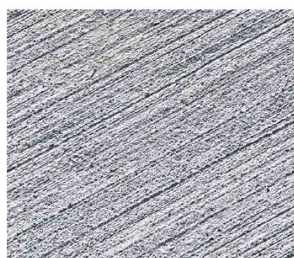
BETON BALAYÉ AU SOL
